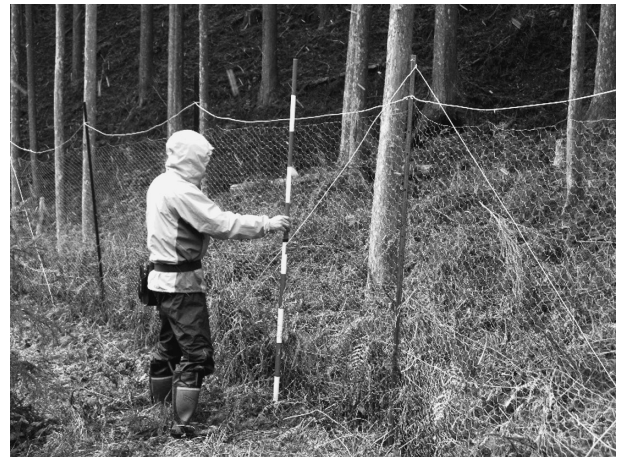
写真-1 県内で設置されている亀甲金網柵
