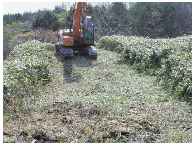
写真-7 刈り払い型による地拵え後の状況
