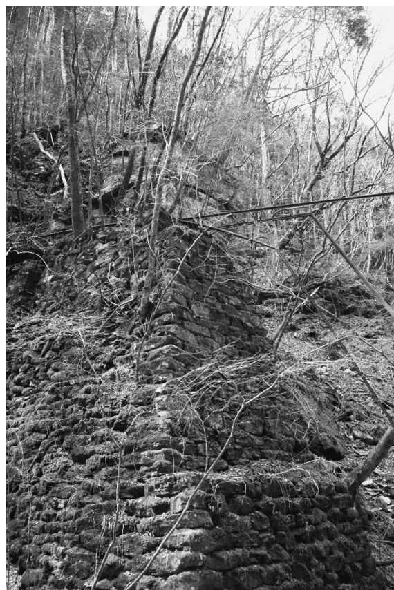
写真-1 石積みの橋台跡
